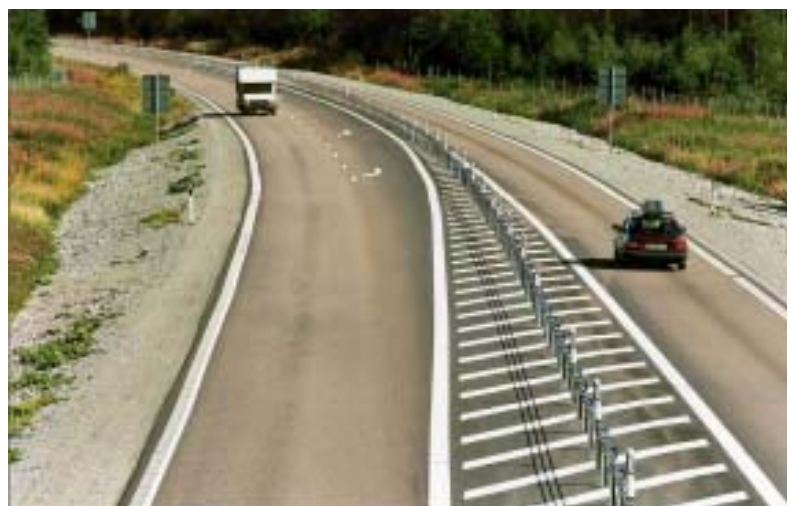
Bild 4: 2+1-väg med mitträcke vid övergång två till ett körfält.
